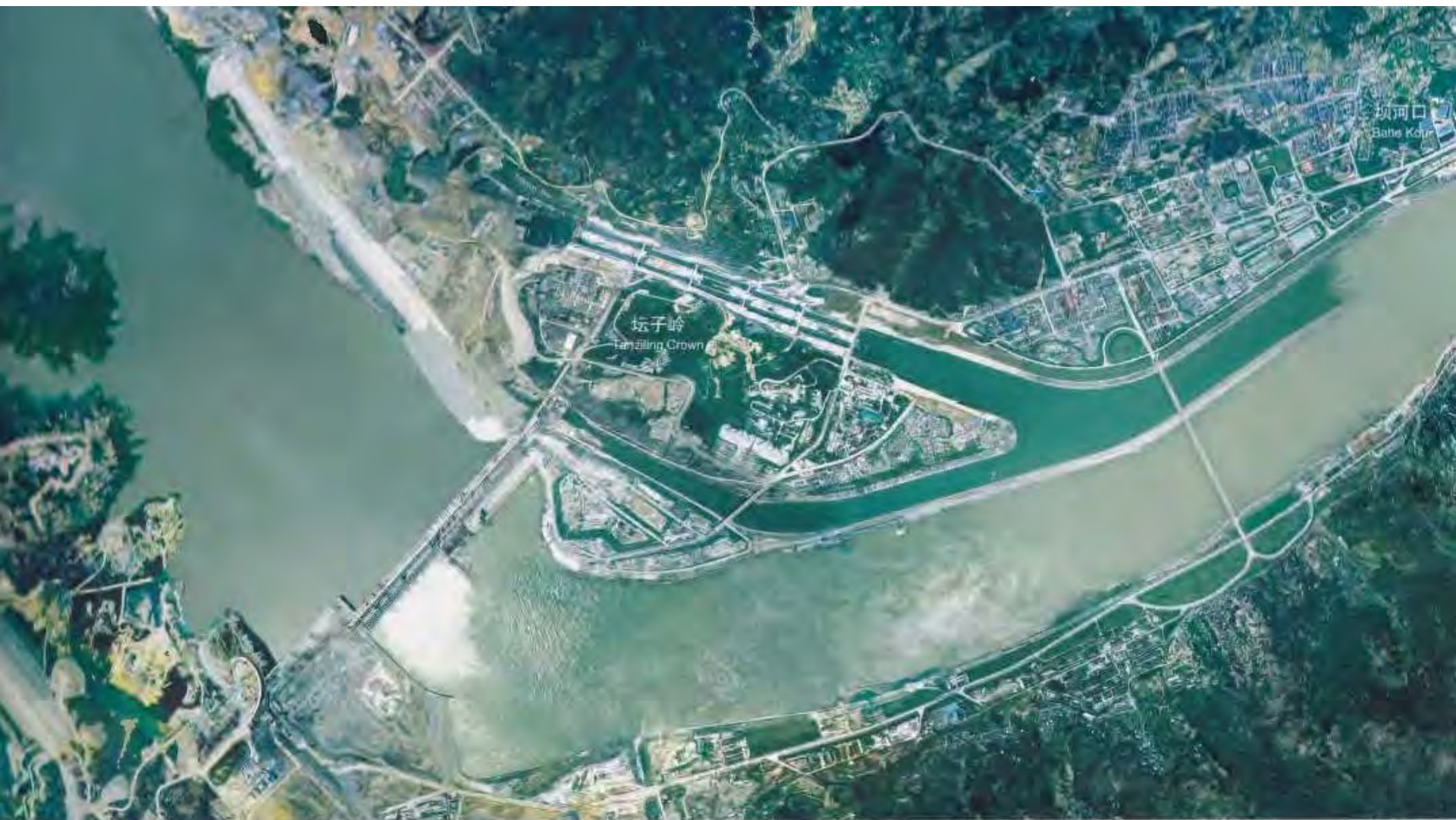
建设中的三峡工程(2003年) The TGP under construction (2003)
