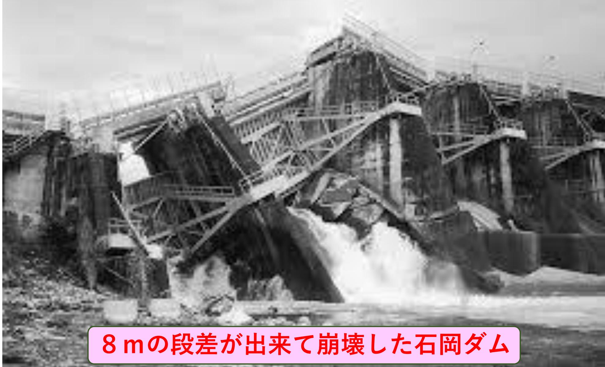
8 mの段差が出来て崩壊した石岡ダム
