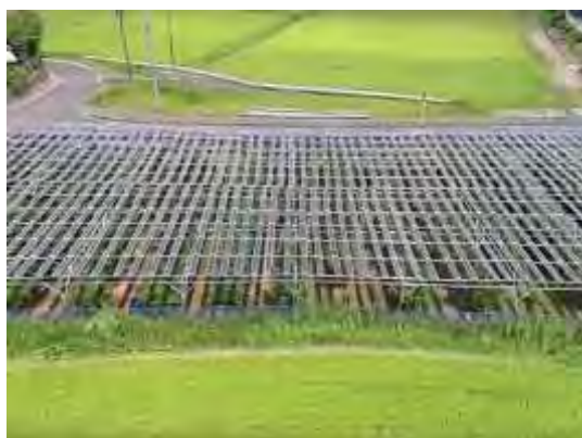
写真3：発電施設の外観
