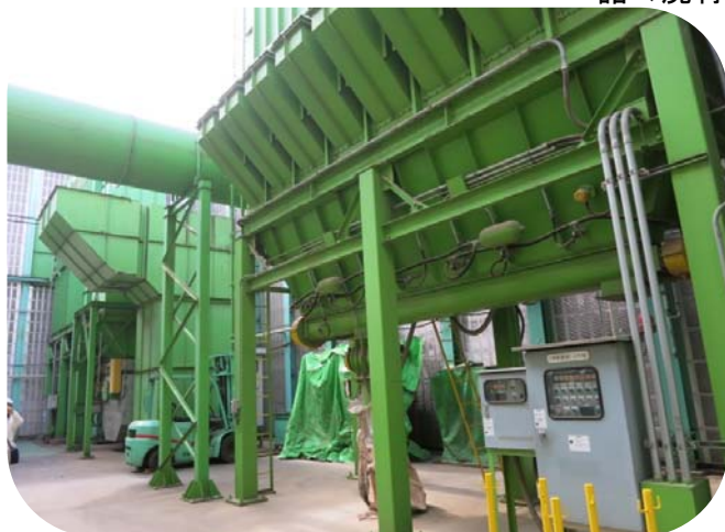
工場内の埃は8機の超大型集塵機で回収している
