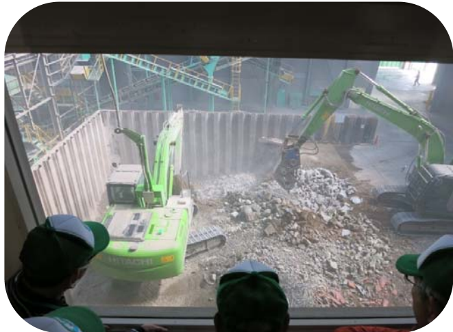
コンクリートの破碎
