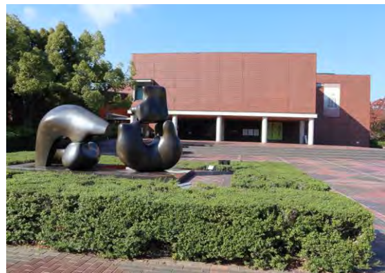
山梨県立美術館本館
