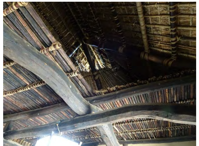
2 階野物材の梁組造りと竹張の床、妻側排煙開口部
