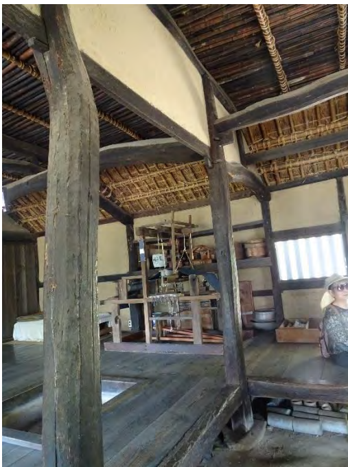
板の間部分のいろり端、野物材の柱と梁組造り
