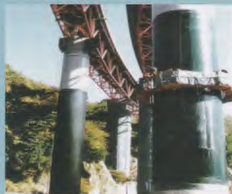
炭素繊維による橋脚の耐震補強
