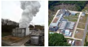
角田航空燃焼試験設備
