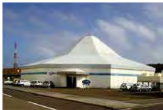
ブロックハウス(BH)打上げ作業場
